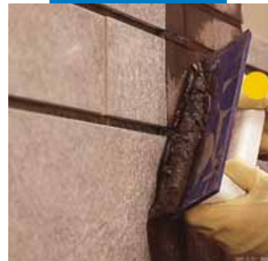
Wandverfugung mit Gummifugbrett
