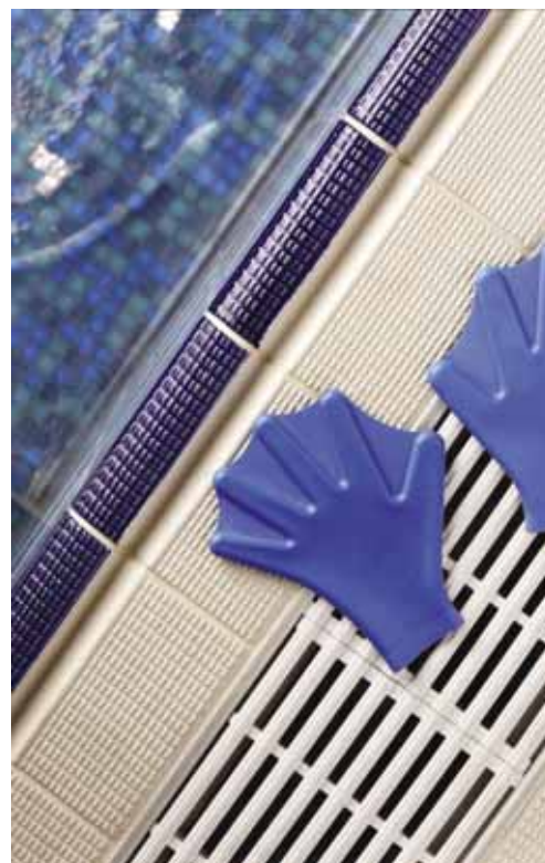
Verfugung eines Keramikbelages mit breiten Fugen im Schwimmbad
