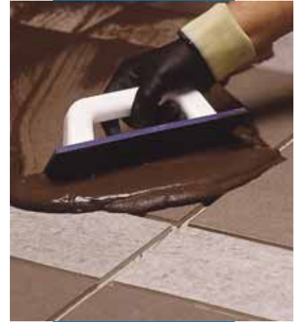
Bodenverfugung mit Gummifugbrett
