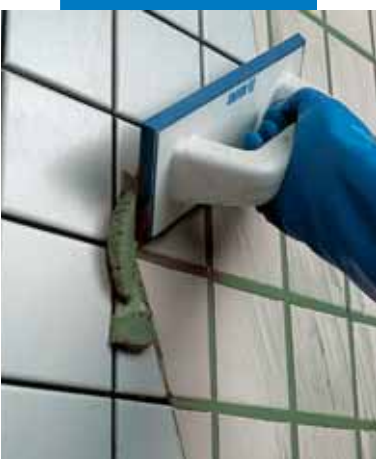
Wandverfugung mit Gummifugbrett
