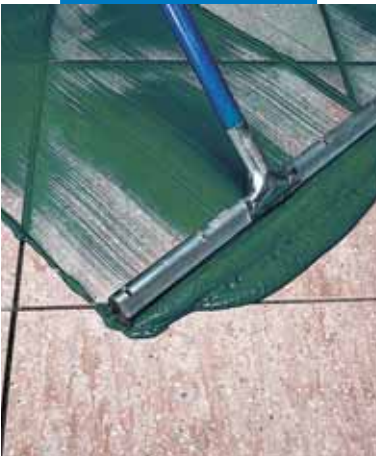
Bodenverfugung mit Gummiwischer
