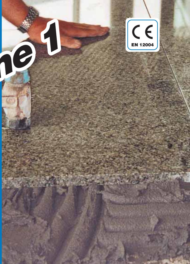
**Flexibler, zementärer, grauer und weißer, kunststoffvergüteter Mittelbettmörtel mit effektiver kristalliner Wasserbindung für Schichtdicken von 5-20 mm im Innenbereich**
